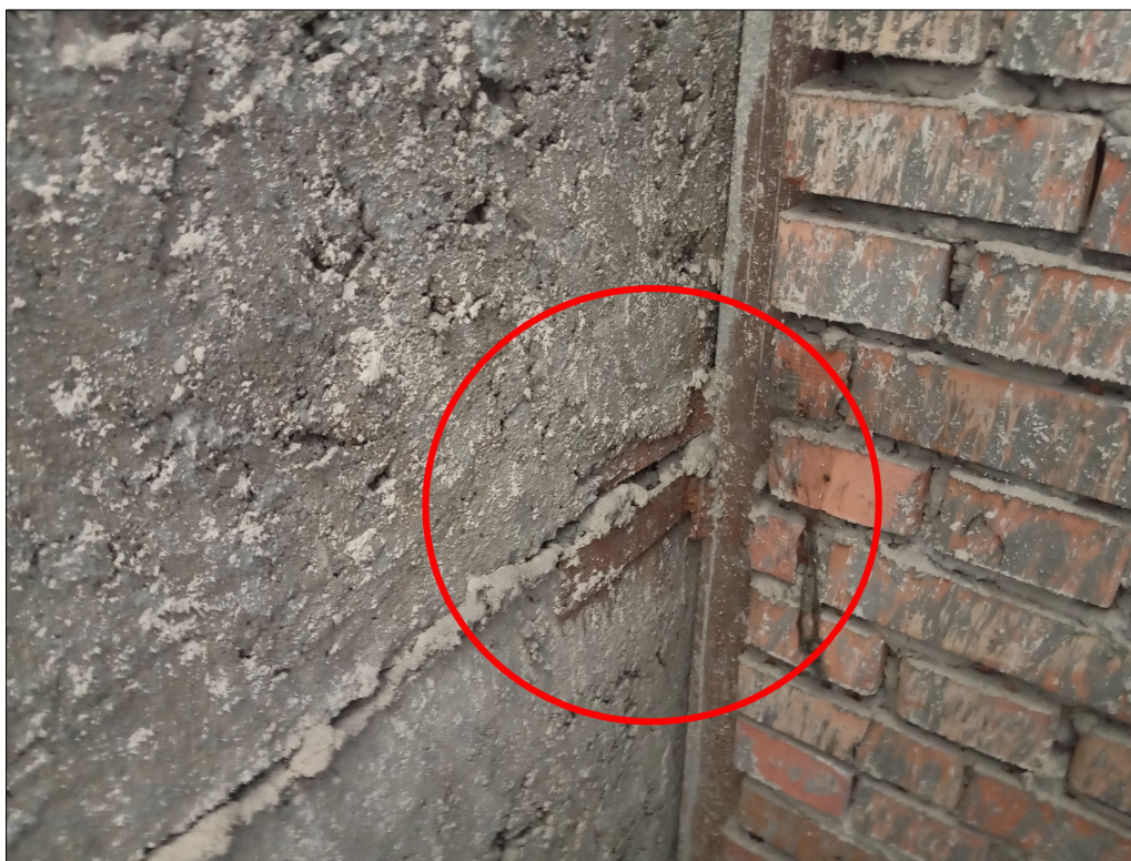
Fot. 10. Szczegół mocowania płyt samonośnych osłonowych za pomocą przyspawanych płaskowników do konstrukcji słupa stalowego o przekroju kwadratowym.
