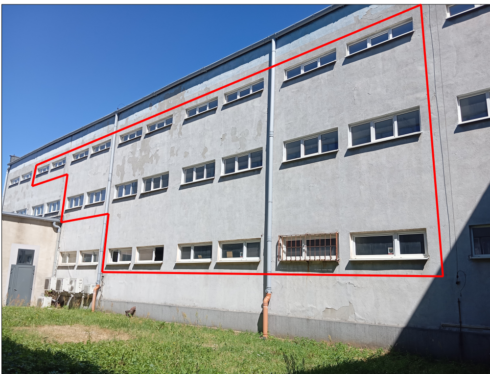
Fot. 5. Fragment elewacji od strony południowej z zaznaczonym obrysem projektowanej stolarki okiennej do powiększenia
