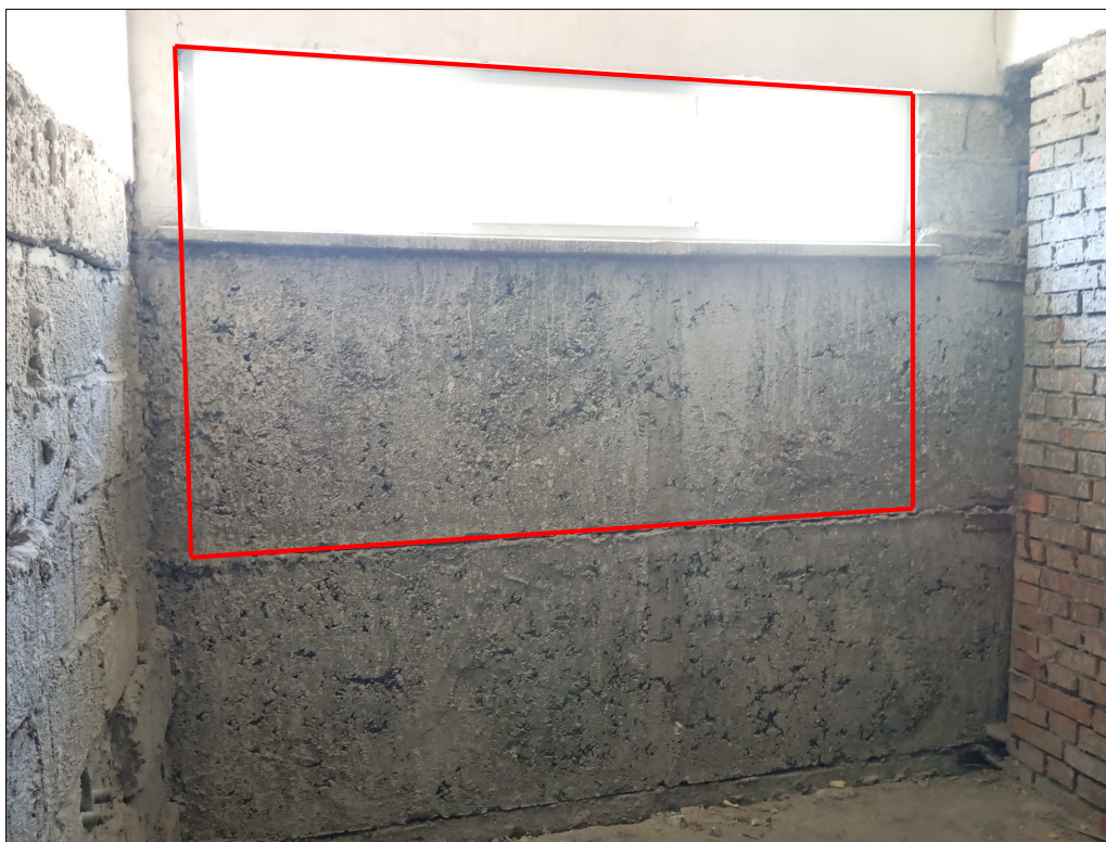
Fot. 9. Widok ściany zewnętrznej z płyt samonośnych osłonowych od wewnątrz z zarysem projektowanego otworu do powiększenia
